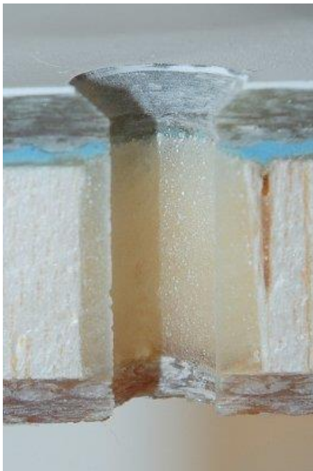
afb. 6 Een opgepot gat, en opnieuw geboord
