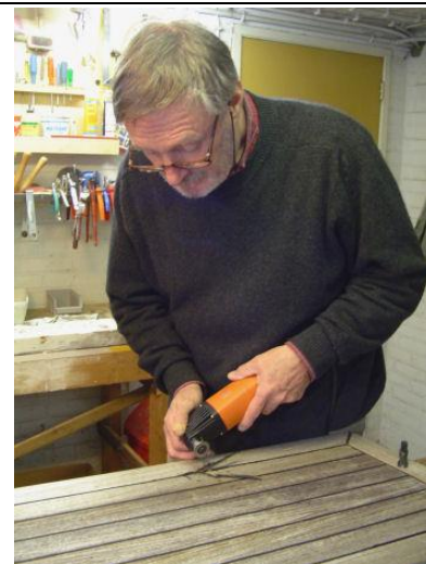
Afb. 7 Verwijderen kit met Fein Multimaster
