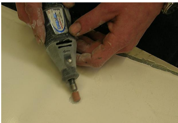
fig. 11 Slijpen met Dremel en slijpsteentje
