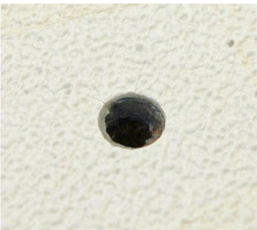
afb. 2 Spinnenweb-barsten door gebrek aan afgeschuinde rand
