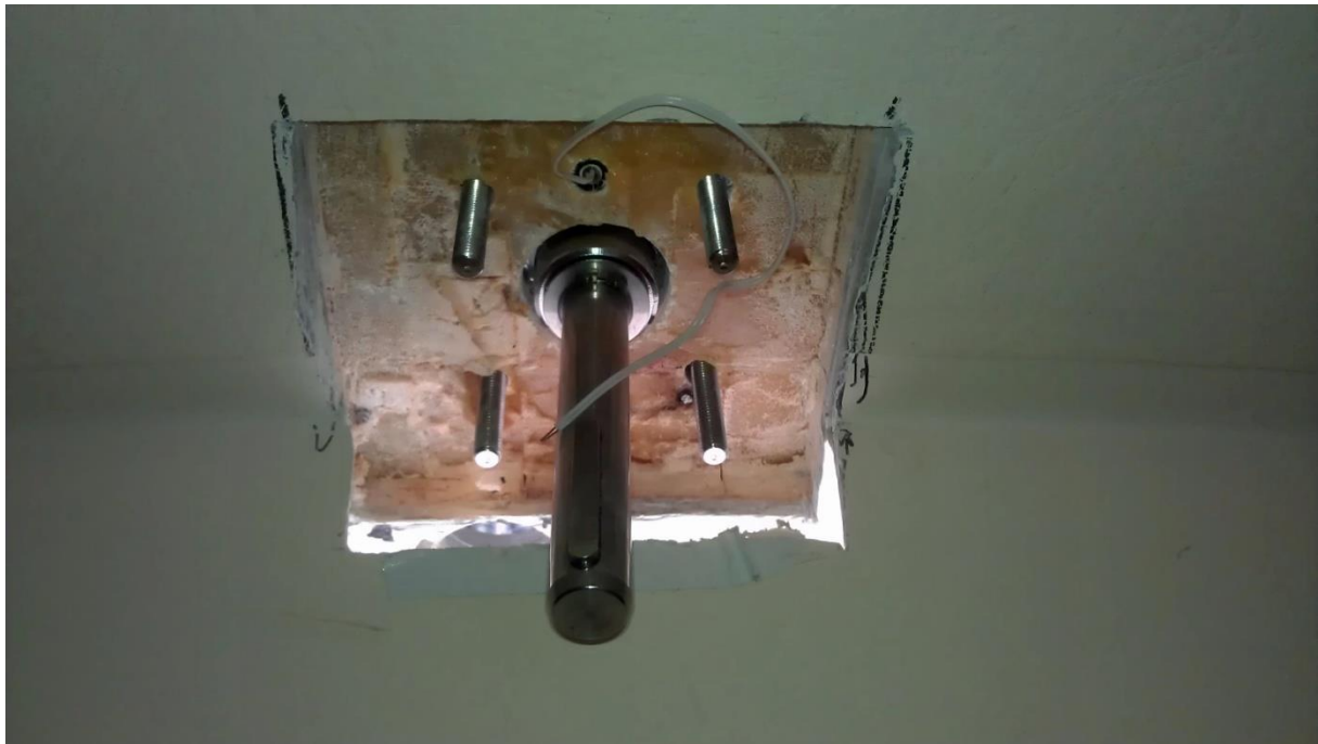
afb. 14 Het bovenste gedeelte van de lier op proef geplaatst
