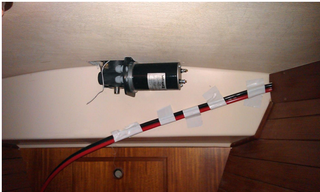
afb. 22 Gemonteerde motor en de accukabel die al getrokken is
