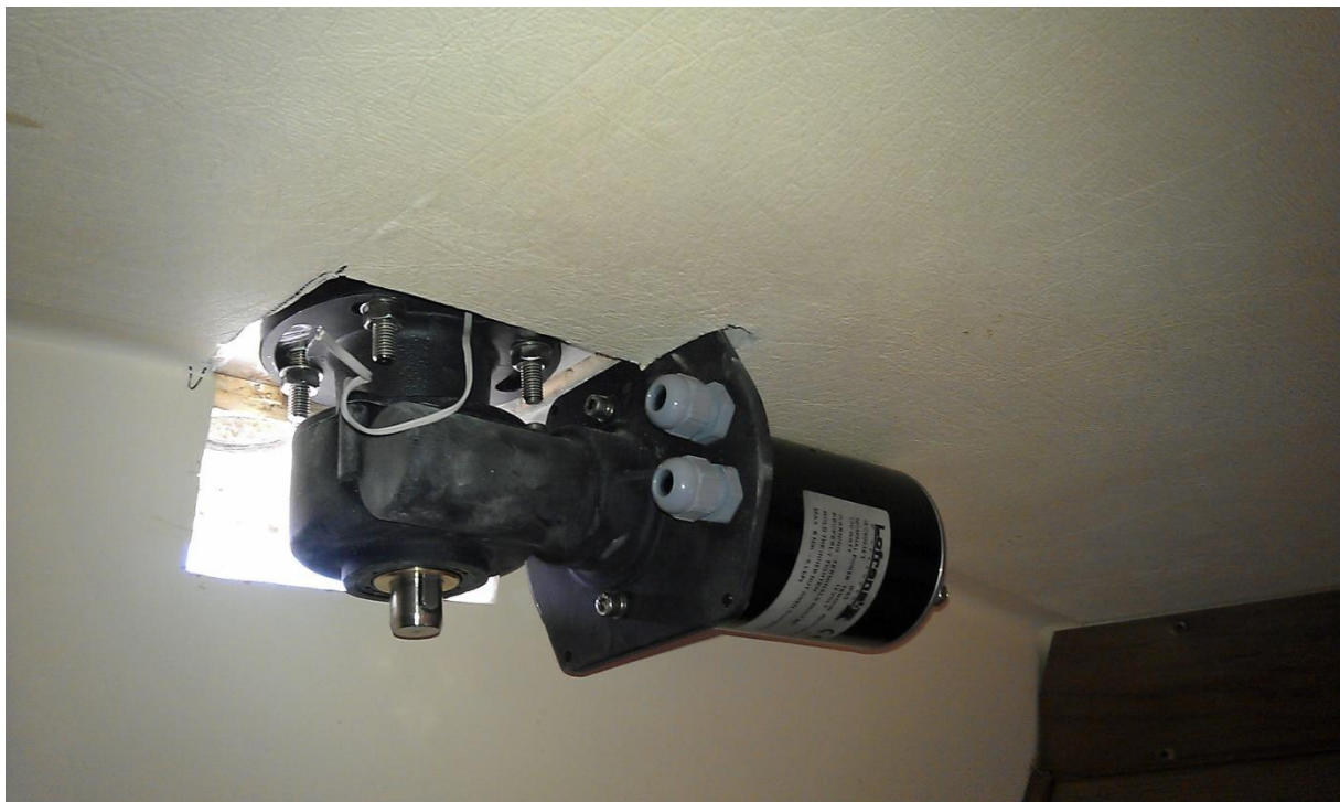
afb. 15 De motor gemonteerd
