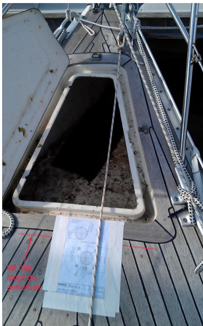
afb. 5 Uitmeten van de montageplek, mal op het dek geplakt
